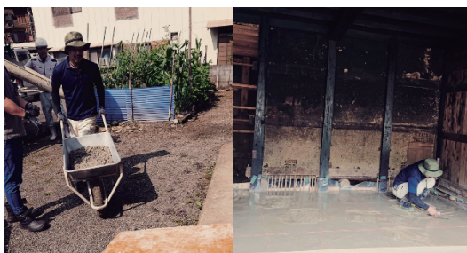
空き家再生作業の様子
